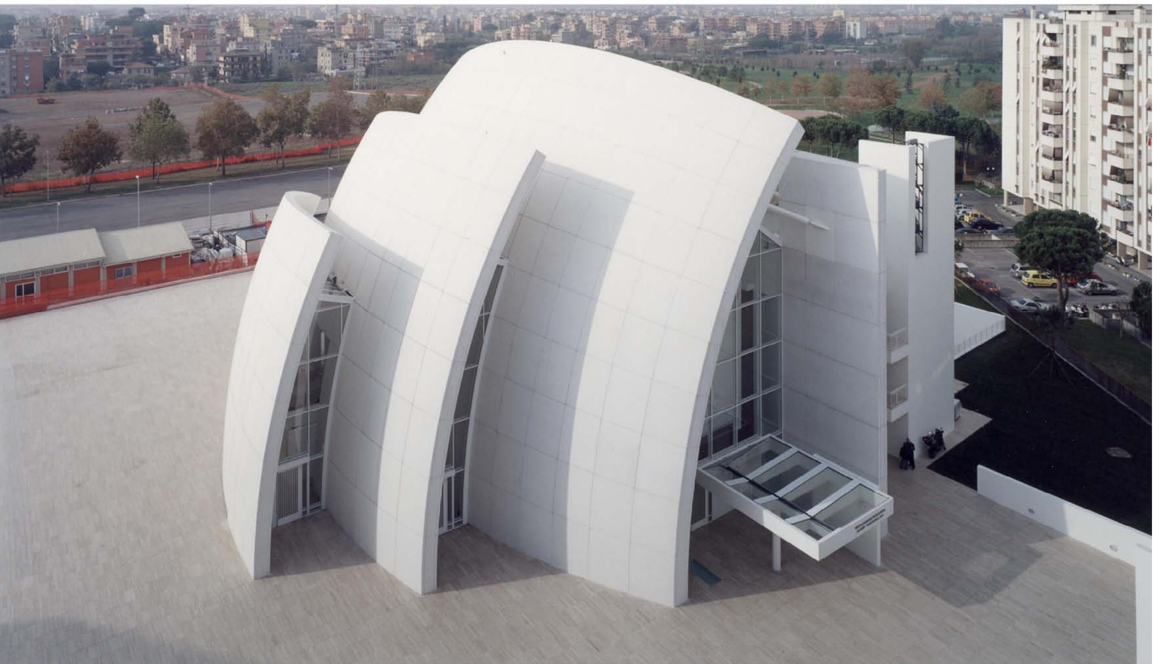
Chiesa Dives in Misericordia, Roma – Italcementi main technical sponsor
